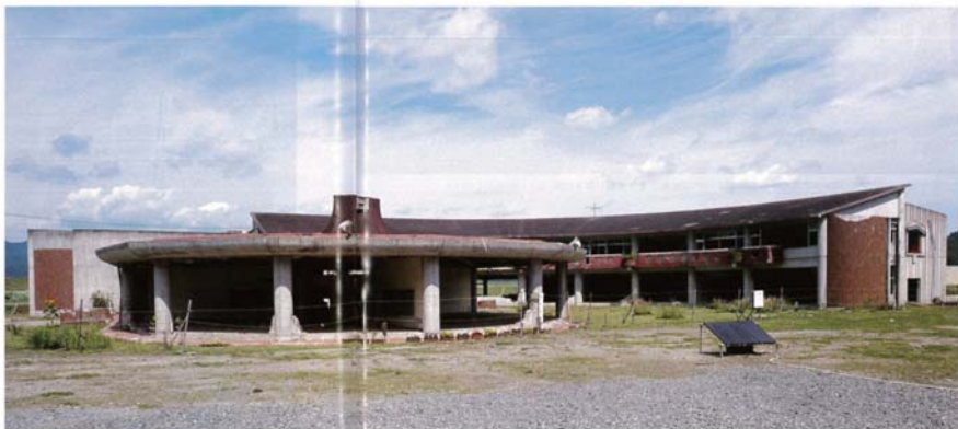
被災した大川小学校校舎。津波は校舎の屋根のほとんどを覆うほどの高さであった
