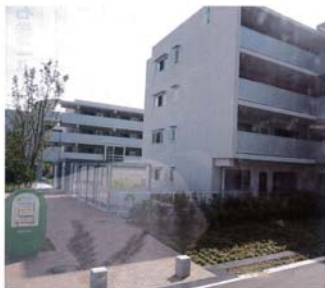
復興住宅は高台に建設されている
