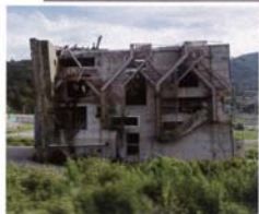
女川町高台より望む女川湾と造成工事の様子。手前には震災当時の建築物が傾転している
